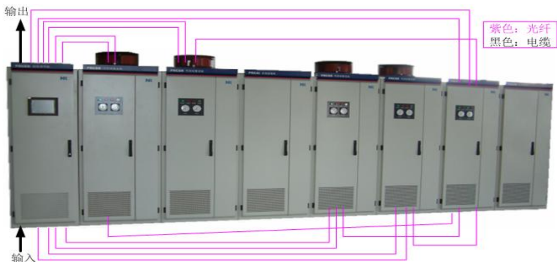
图 4 PCS-9400 智能励磁系统光纤连接示意图
